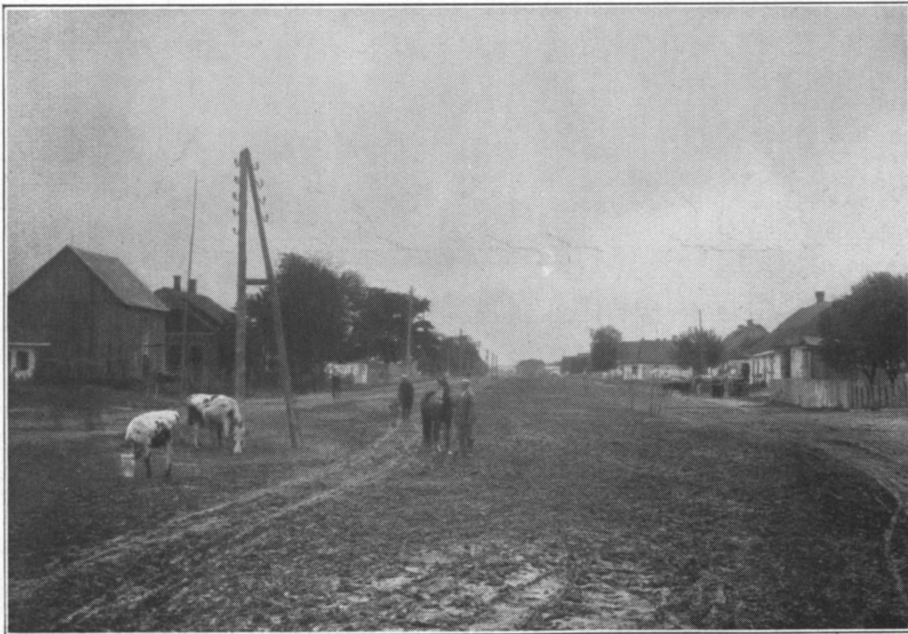
Kolonie Jeziorany (Polen). Eine Straße in der Kolonie.
